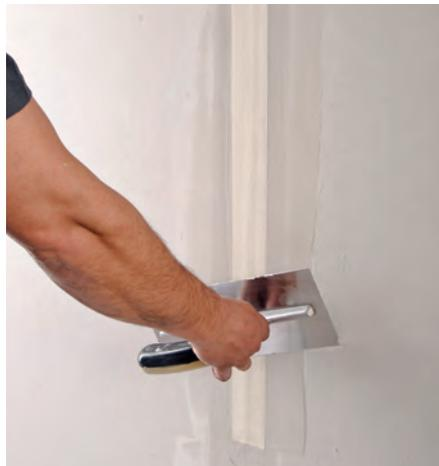
Bewehrungsstreifen glatt ziehen; Spachtelschicht abbinden lassen
